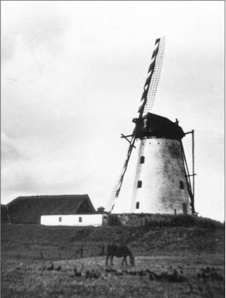
Die Huisberdener Mühle, von der Kalfack aus gesehen. Wilhelm van Laack ersetzte die alte hölzerne Bockwindmühle 1827 durch eine steinerne Turmwindmühle. Kurz nach 1945 wurden zwei Flügel wegen Baufälligkeit abmontiert.
